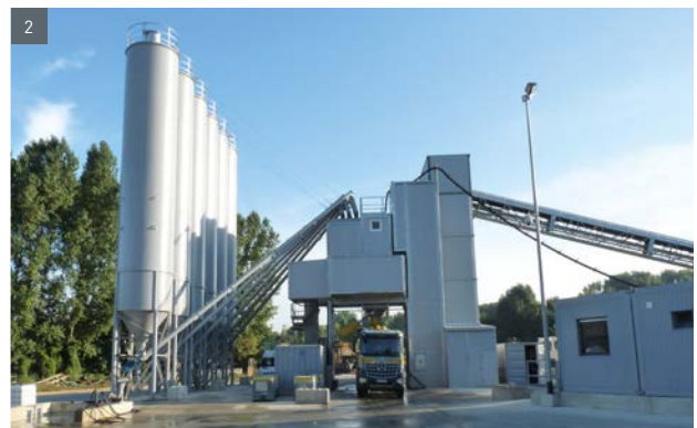
1. Beschickung Hochbunker mittels Gurtbecherwerk / Feeding of container hopper by bucket elevator ■ 2. Beschickung Hochbunker mittels Förderband / Feeding of container hopper by belt conveyor
