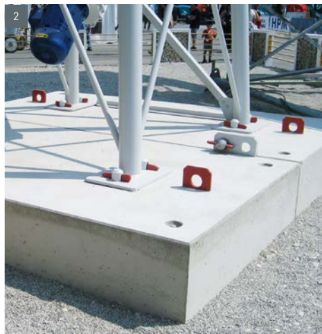
1. Bindemittelsilo 69 m 3 | 85 t mobil / Cement silo 69 m 3 | 85 t mobile ■ 2. Mobilfundamente / Mobile foundations ■ 3. 3-Achs-Fahrwerk / 3-axle-chassis
